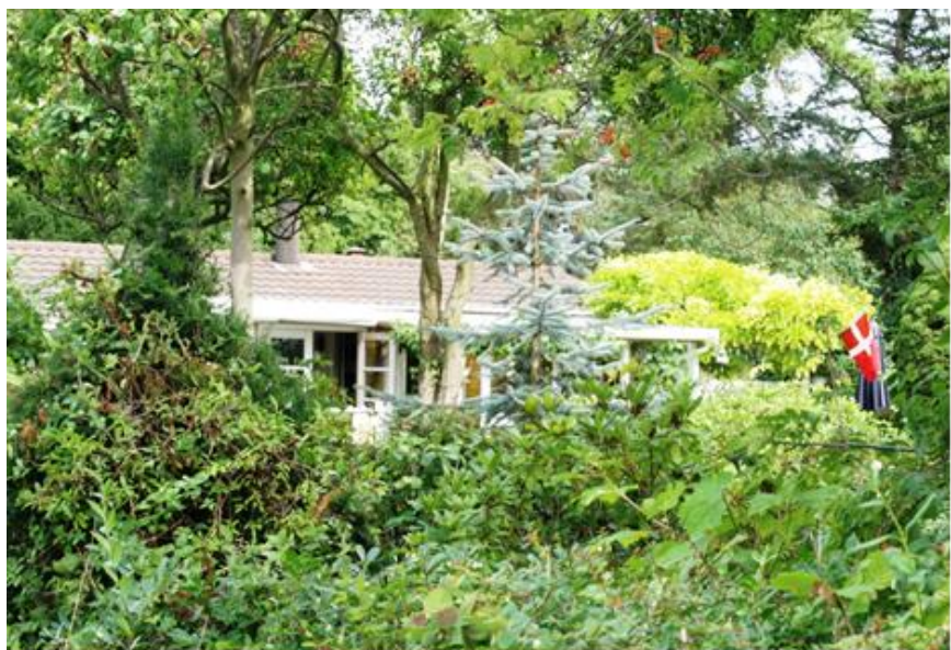
Et af de sommerhuse, som ønskes overført til byzone
